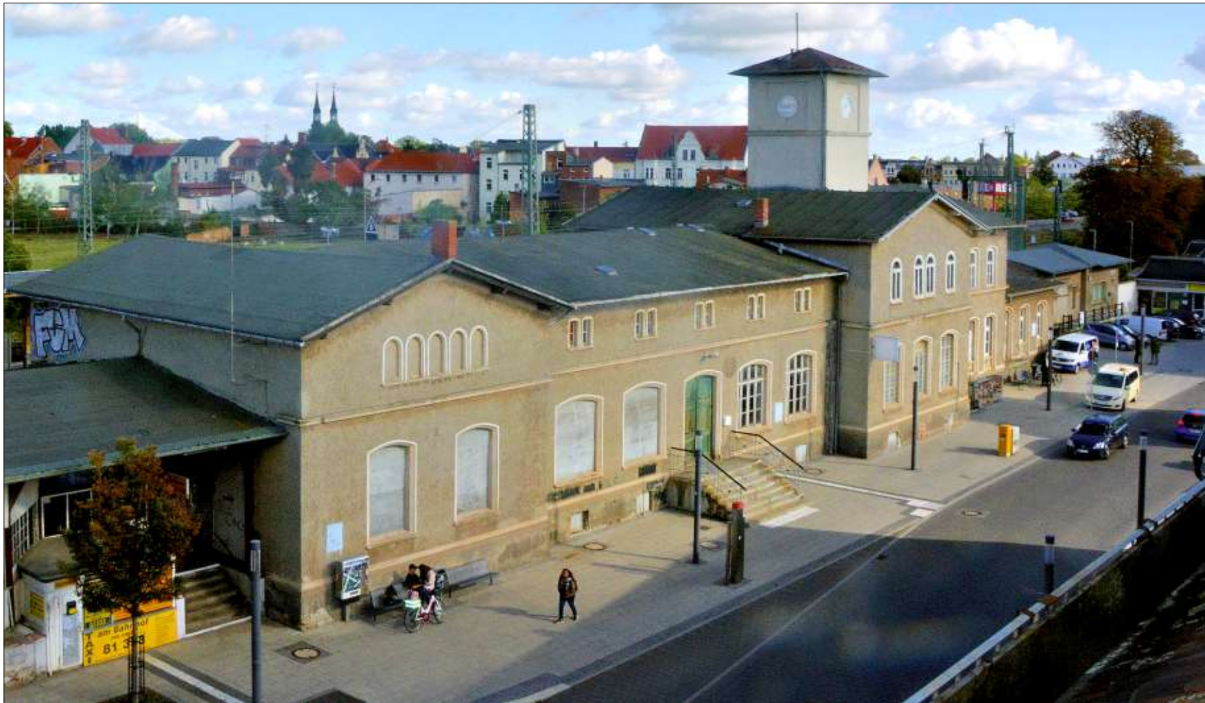
Ein schönes Aushängeschild ist der Schönebecker Bahnhof wahrlich nicht. Doch das soll sich ändern. Die Städtische Wohnungsbau GmbH (SWB) hat nun Fördermittel in Höhe von zwei Millionen Euro erhalten, um dem alten Gebäude neues Leben einzuhauchen.
