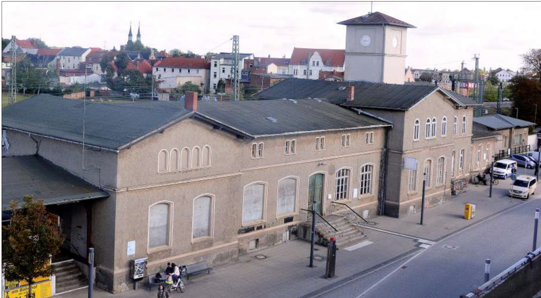
Auch ein Jahr nach der Zusage von Fördermitteln über zwei Millionen Euro hat sich am und im Schönebecker Bahnhof nichts getan. Die Pläne der SWB zur Modernisierung des Bahnhofs werden von einer weiterhin fehlenden Baugenehmigung ausgebremst
