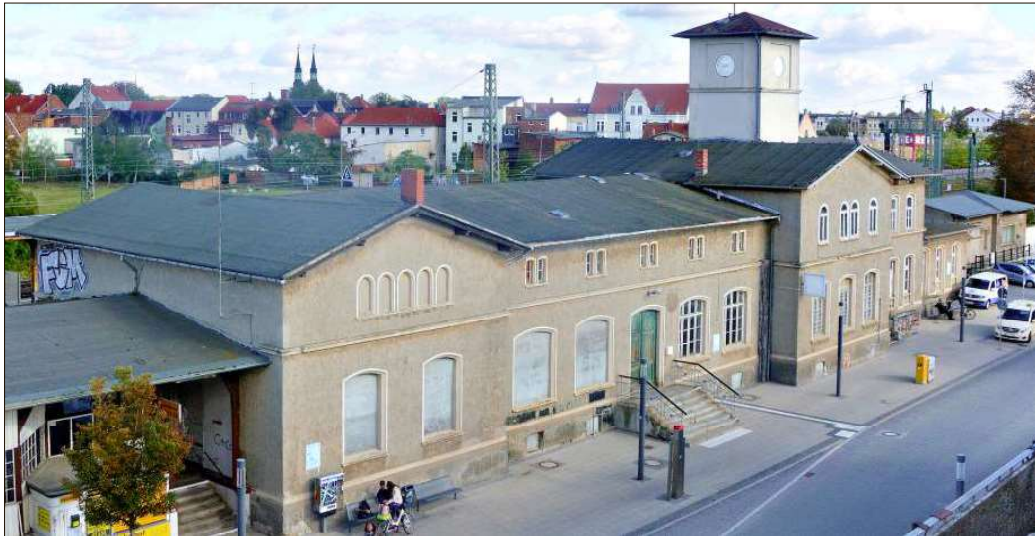
Die SWB will den Bahnhof von Schönebeck sanieren und mit neuem Leben füllen. Unter anderem ein Hostel und eine Fahrradwerkstatt sollen ihren Platz finden. Doch der Start der Arbeiten verzögert sich immer wieder.
