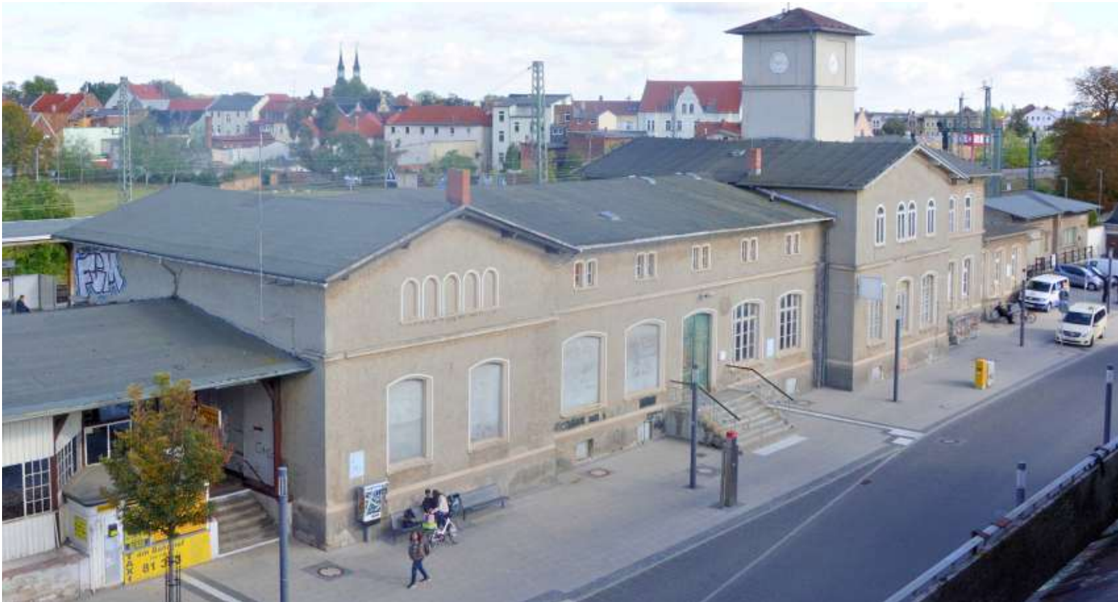
Mit der Sanierung des Bahnhofs Schönebeck soll im ersten Halbjahr 2024 begonnen werden.
